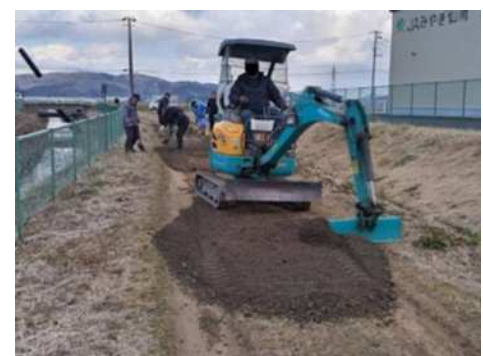
共同作業（農道補修）の様子
