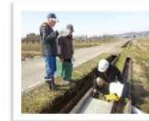
ダブル水路間土砂溝畔のコンクリート張り（砂田地区）
