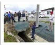
点検・機能診断
