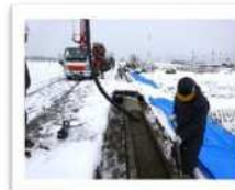
ダブル水路間土砂溝畔のコンクリート張り（砂田地区）
