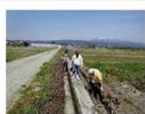
堰払い（泥上げ）
