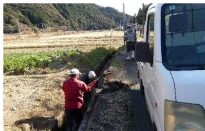
水路の泥上げ作業の様子
