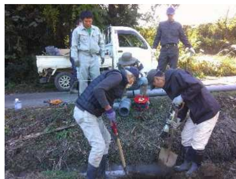
用水路のパイプライン化
