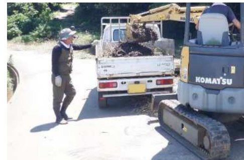
水路の泥上げ
