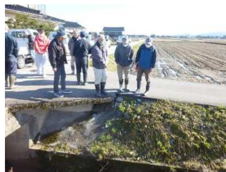
みんなで回る 地域危険箇所の点検
