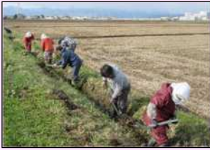
水路の泥上げ
