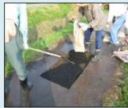
農道の部分補修
