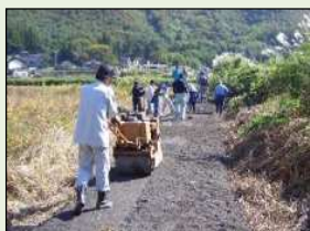
未舗装農道の舗装
