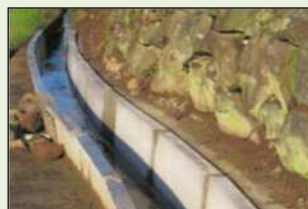
素堀り水路からの更新
