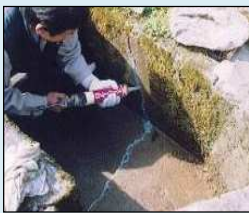
ひび割れの補修
