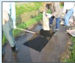
農道の部分補修
