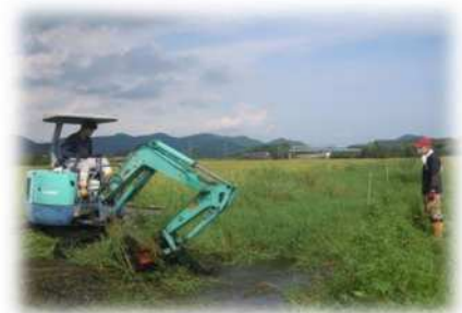
重機で泥上げをする様子
