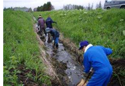
排水路の泥上げの様子
