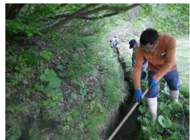
水路の泥上げ
