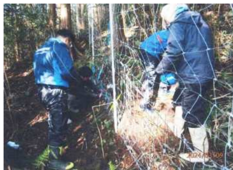
防護柵の点検・補修
