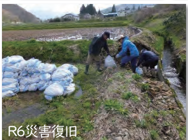
漏水対策・取水堰止め
