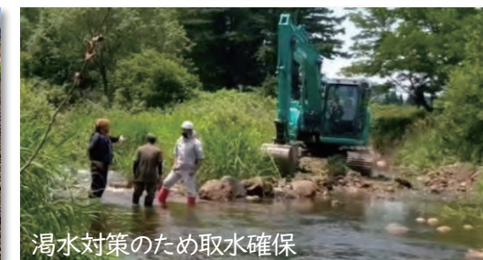
直営施工による水路設置
