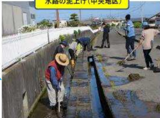
水路の泥上げ(中央地区)
