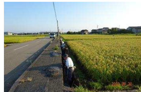
泥上げの様子
