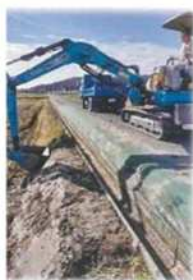
畦畔補修作業
