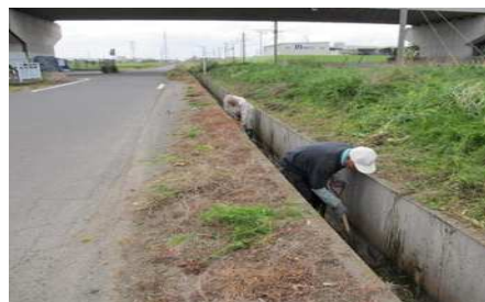
水路の泥上げ
