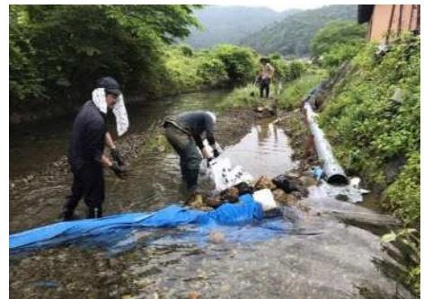
水路清掃・勾配修繕
