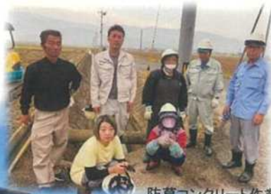
防草コンクリート作業
