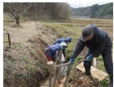
農道の法面補修
