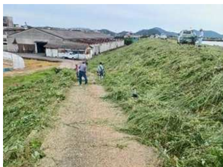
ため池法面の草刈り
