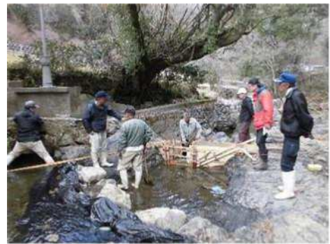
取水口の補修作業 (構成員による直営施工)
