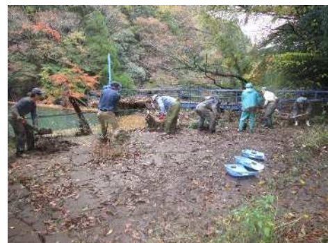
取水口付近の土砂撤去
