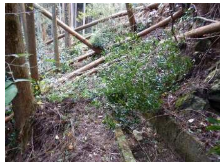
台風 14 号による 被害の概要（水路の埋没）
