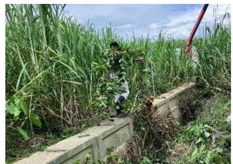
水路伐開の様子
