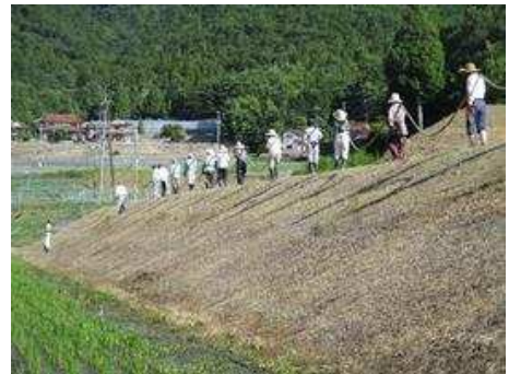
センチピードグラス吹付作業
