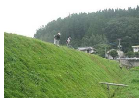
植生定着後草刈り作業(農道)
