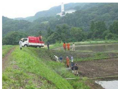
農道吹付け作業
