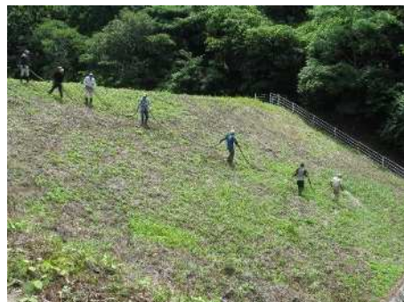
ため池堤体吹付け作業
