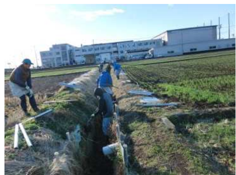
地域住民による排水路土留め工事
