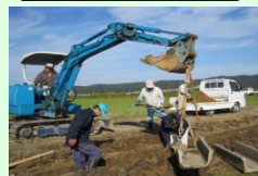
コンクリート水路の更新
