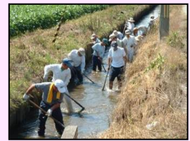
水路の泥上げ
