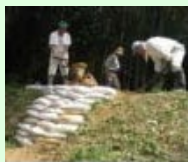
漏水箇所の補修
