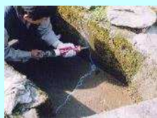
水路のひび割れ補修
