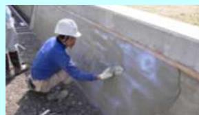
老朽化した水路壁のコーティング
