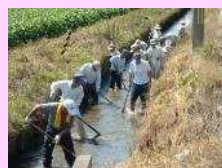
水路の泥上げ
