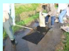
農道の部分補修
