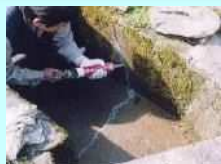
水路のひび割れ補修
