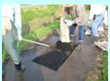
農道の部分補修
