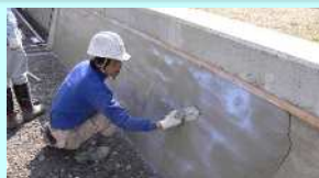
老朽化した水路壁のコーティング
