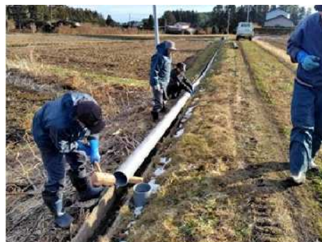
老朽化した水路の補修の様子
