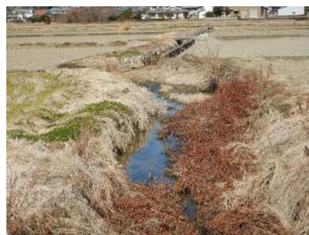
地域内の土水路
