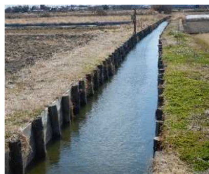
「松杭を打っている水路」 メダカやタナゴなどの水生生物が生息している。
