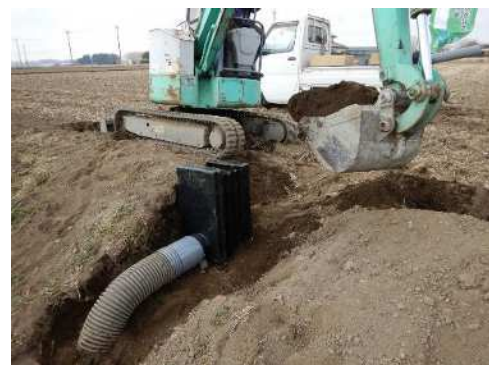
排水柵の設置 (田んぼダム)
