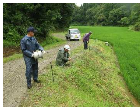
電気柵の設置
