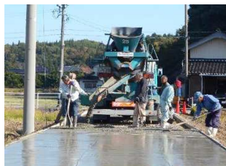
農道のコンクリート舗装
