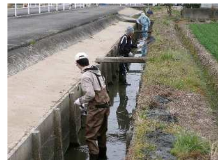
水路の泥上げの様子
