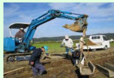
コンクリート水路の更新
