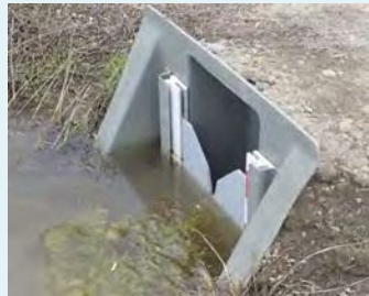
流出を抑制する落水量調整装置の例
