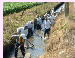
水路の泥上げ
