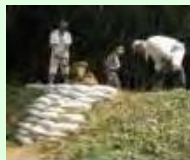
漏水箇所の補修
