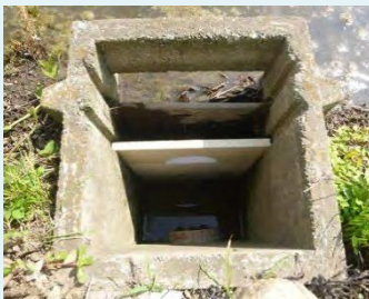
流出を抑制する落水量調整装置の例
