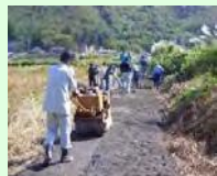
未舗装農道の舗装
