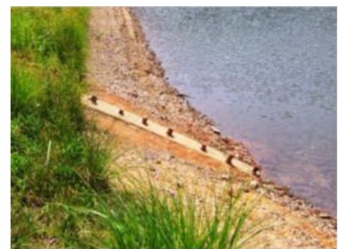
斜樋と取水栓
