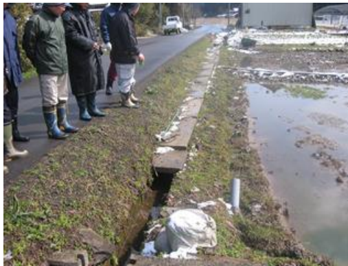
開水路の点検状況
