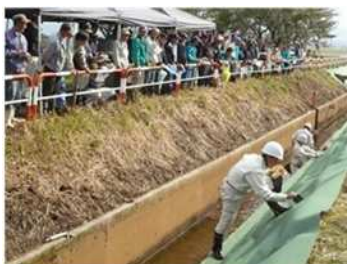
土地改良区主催の 水路補修の技術研修会
