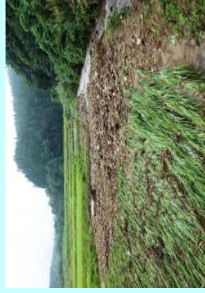
用水路決壊及び農地土砂堆積
