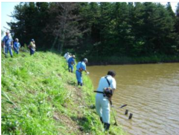
ため池堤体の草刈り
