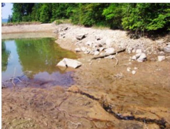
ため池に流入した土砂
