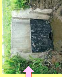
水位調整板設置状況
