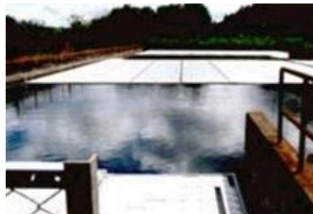
浮揚型の天蓋による部分遮光
