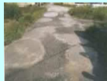
農道の窪みの補修
