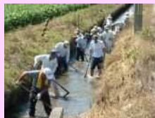
水路の泥上げ
