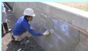
老朽化した水路壁のコーティング
