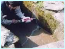
水路のひび割れ補修
