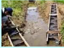
水田魚道の設置
