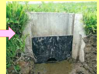
水位調整板設置状況
