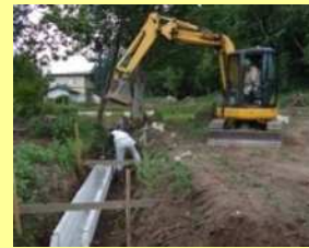
自主施工の実施
