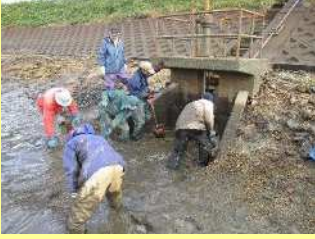
ため池の泥上げ作業
