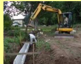
自主施工の実施
