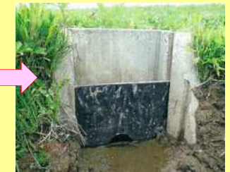
水位調整板設置状況
