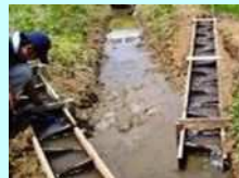
水田魚道の設置
