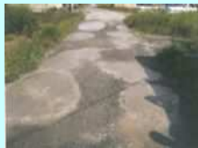
農道の窪みの補修
