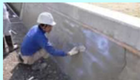
老朽化した水路壁のコーティング
