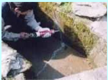
水路のひび割れ補修
