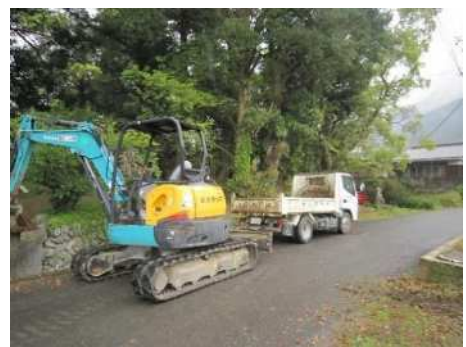
自治会を通じて手配した重機
