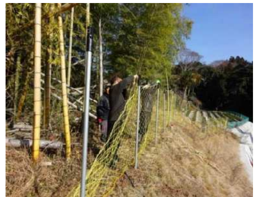
獣害防護柵の設置
