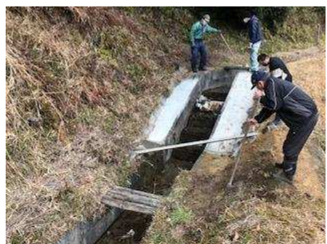
水路補修の様子
