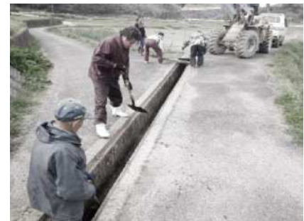
水路の泥上げの様子
