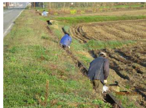
水路の泥上げ作業の様子
