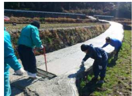
コンクリート舗装の様子
