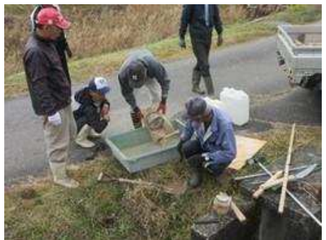
水路の補修作業 (直営施工)
