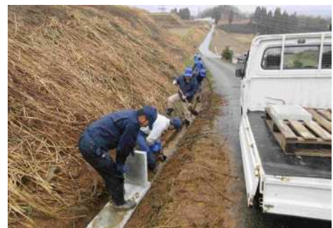
自作の水路蓋の設置
