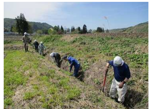
水路の泥上げの様子
