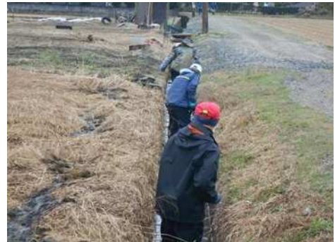
水路の泥上げの様子
