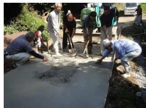
農道舗装の様子
