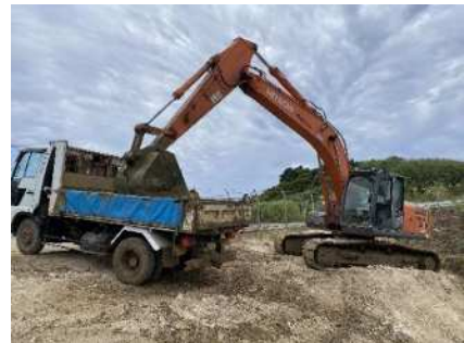
浸透池の泥上げ
