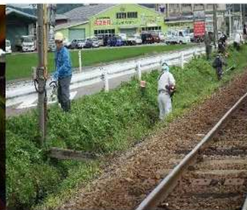
水路・路肩部の草刈り 7/2
