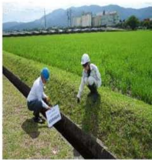
役所保全管理状況立会 6/27
