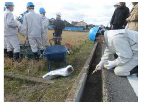
水路のコーティング作業
