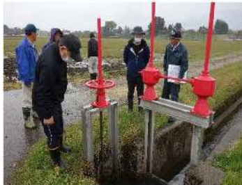
水門等の点検・診断 4/15
