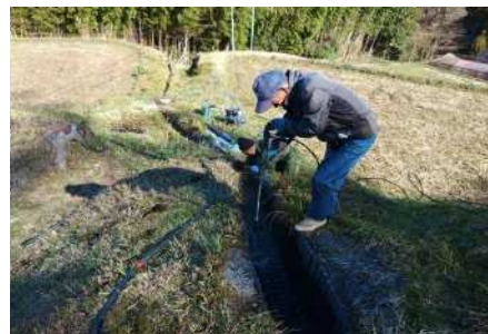
農業用水路の補修作業
