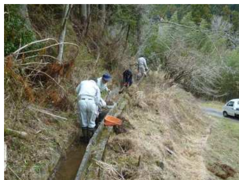
水路の泥上げの様子
