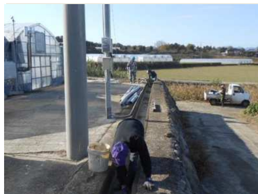
水路補修活動の様子
