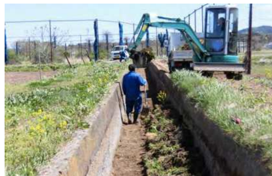
水路の泥上げ作業の様子
