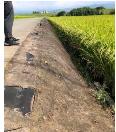
防草シート設置
