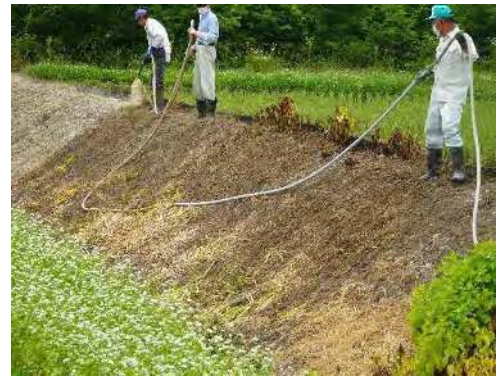
芝の吹き付け作業
