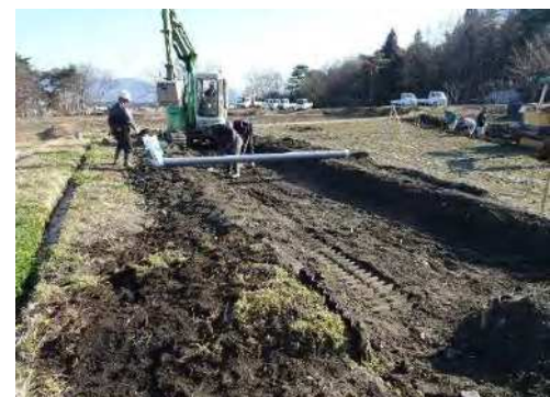
建設中のホテル水路
