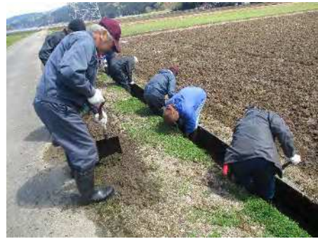
水路の泥上げ
