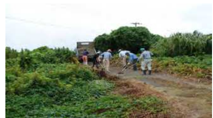
農道整備（再生砂利の敷き均し）
