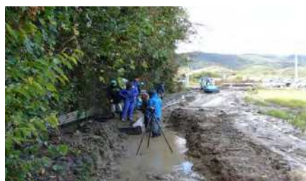
ビオトープ整備（あぜ波設置）
