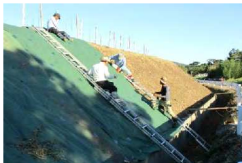
共同活動による防草シート施工
