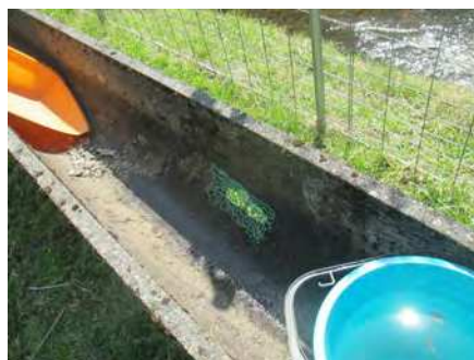
集落の直営で水路補修
