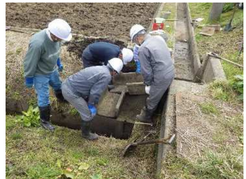
水路の補修作業
