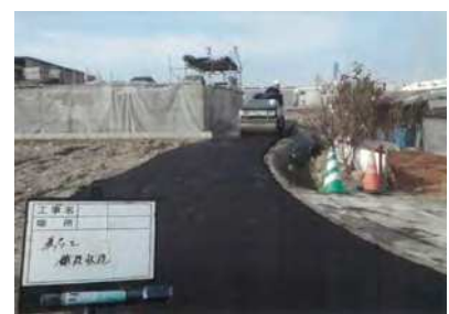
農道舗装の様子
