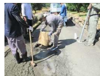
農道の補修作業の様子
