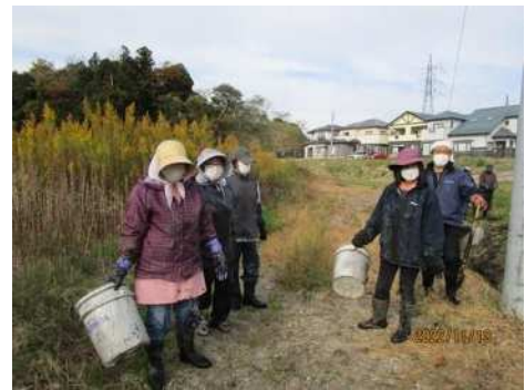
水路の泥上げ・清掃の様子
