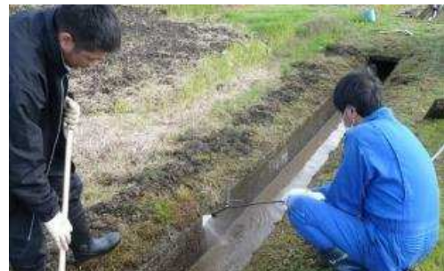
水路補修前の準備作業
