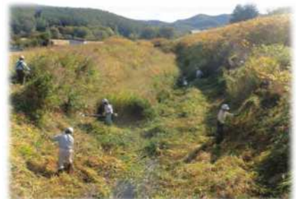
排水路の草刈り
