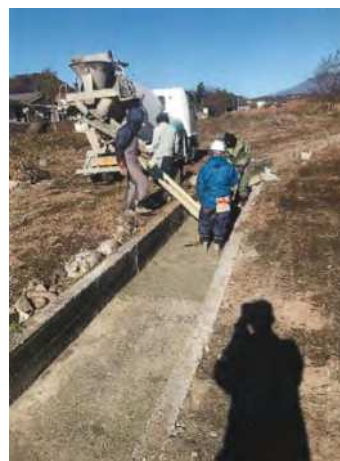
直営施工による水路の補修
