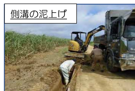
浸透池の泥上げ
