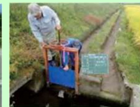
地区の管理ゲート一括補修
