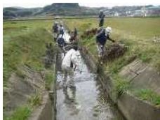
水路の泥上げ
