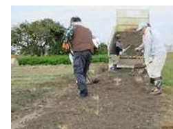
農道の窪みの補修
