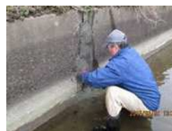
水路のひび割れ補修
