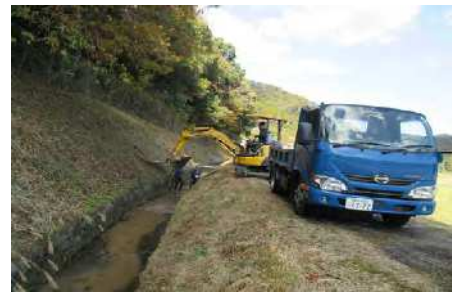
水路の泥上げ作業
