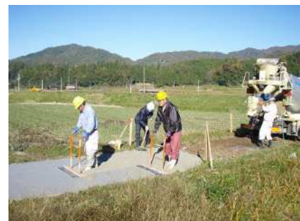
直営施工による農道舗装
