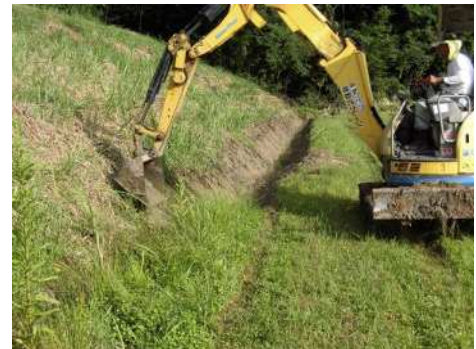
法面補修(獣被害)活動の様子
