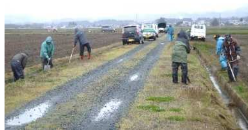
水路の泥上げ作業
