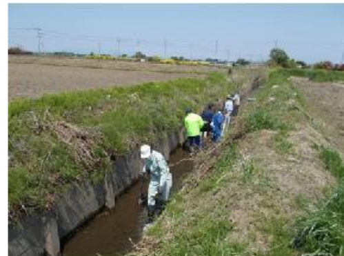
排水路の泥上げ作業
