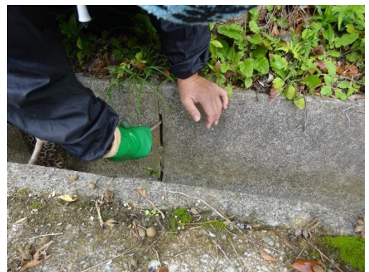
U字溝の目地を補修する様子
