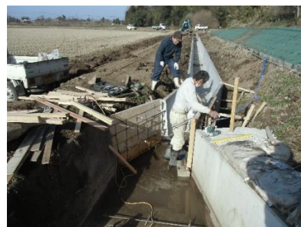
水路の更新工事 資源向上(長寿命化)
